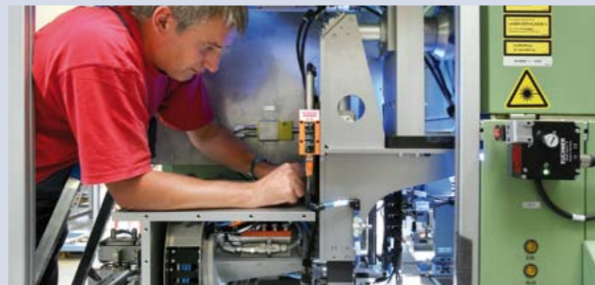
Aufbau einer Laserschweißstation als Teil einer komplexen Fertigungsstraße
